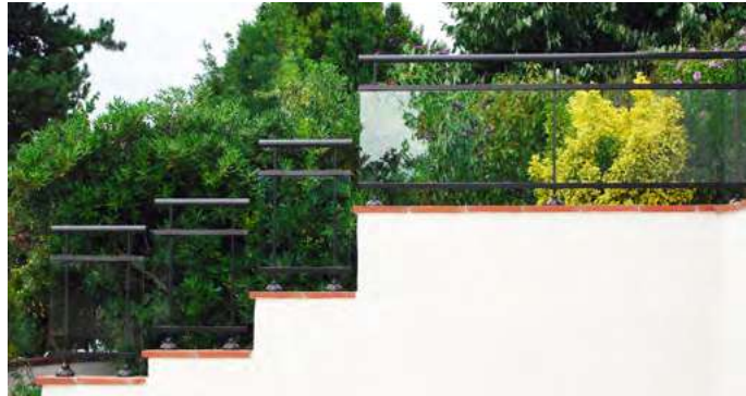
Droit sur dalle
