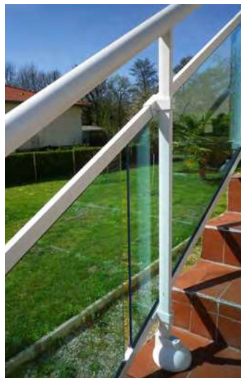
Rampant sur plat de marche
