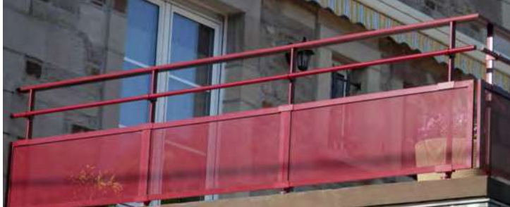
Droit sur dalle
