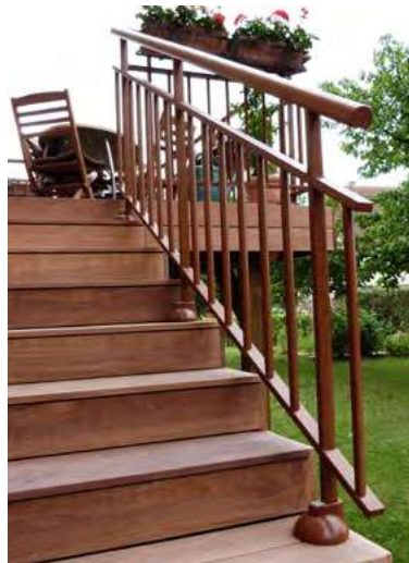
Rampant sur plat de marche
