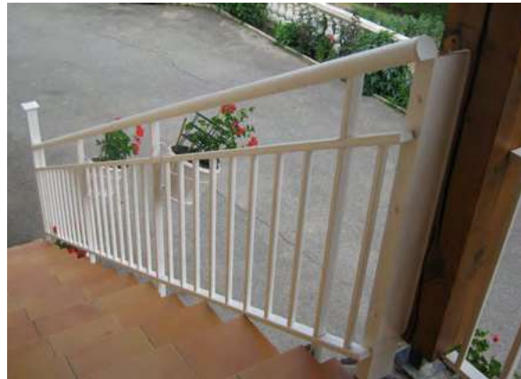
Rampant sur nez de dalle
