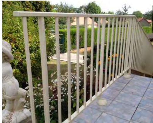
Droit sur dalle
