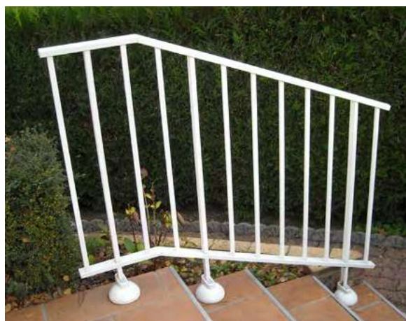
Rampant sur plat de marche
