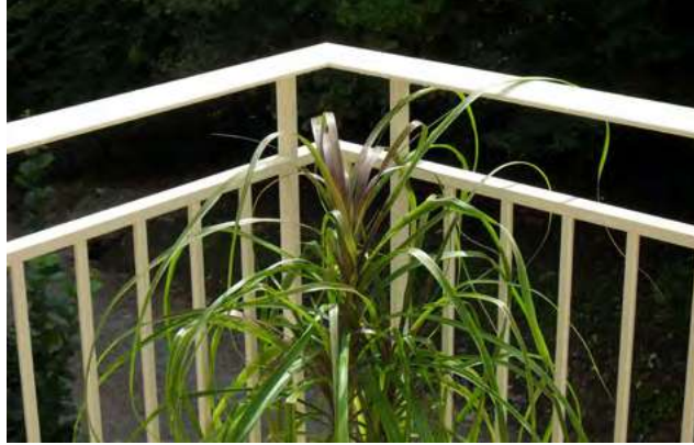
Droit sur dalle
