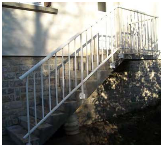
Rampant sur nez de dalle
